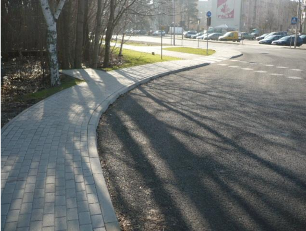
fotografia 2 Pętla przy ulicy Batorego – miejsce do zawracania
