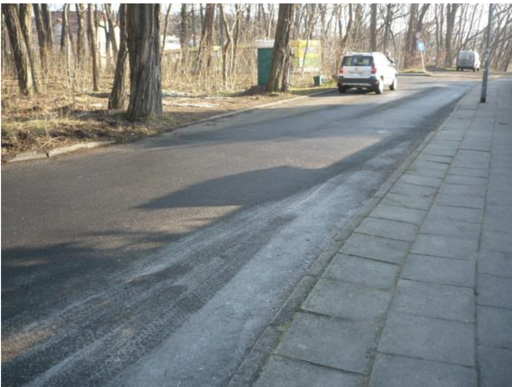
fotografia 28 Pętla przy ul Wyczółkowskiego miejsce postoju
