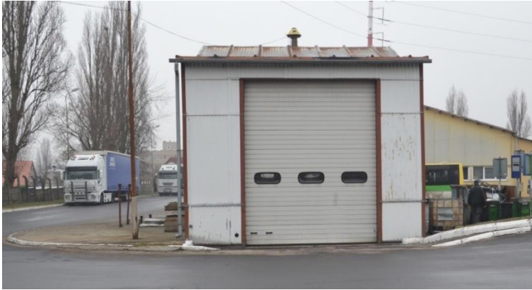
foto 56 – ST 40/103 elewacja południowa
