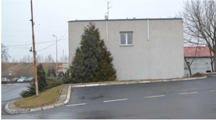
foto 28 – ST 5/105 elewacja południowa
