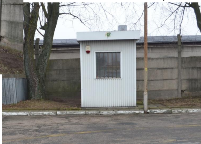
foto 63 – ST 494/109 elewacja wschodnia
