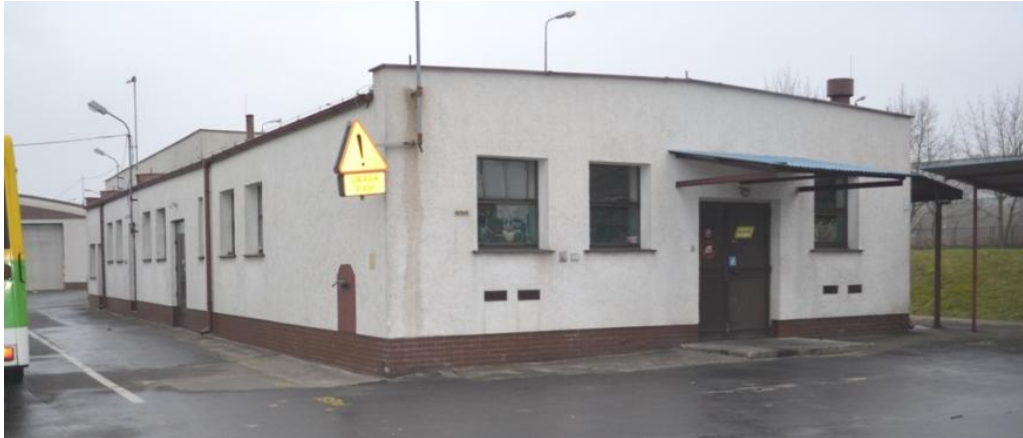
foto 33 – ST 6/109 elewacja północno-zachodnia
