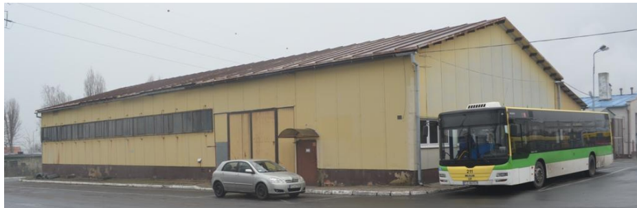
foto 50 – ST 10/104 elewacja południowo-zachodnia
