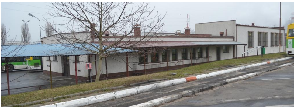
foto 36 – ST 6/109 elewacja południowo-zachodnia
