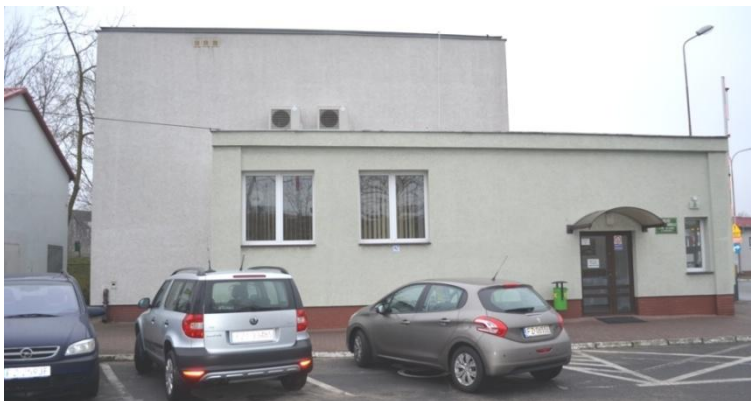
foto 26 – ST 5/105 elewacja północna
