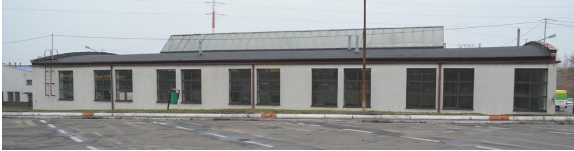
foto 24 – ST 4/103 elewacja południowa
