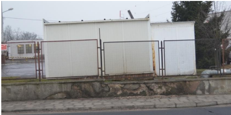
foto 60 – ST 43/109 elewacja północna
