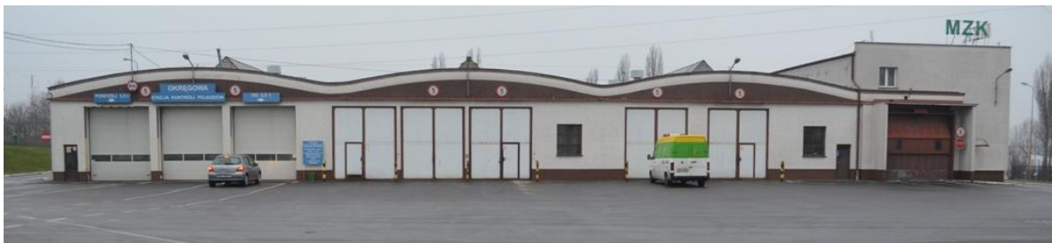
foto 22 – ST 4/103 elewacja wschodnia
