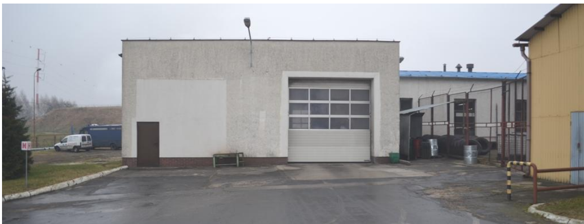
foto 47 – ST 9/103 elewacja zachodnia
