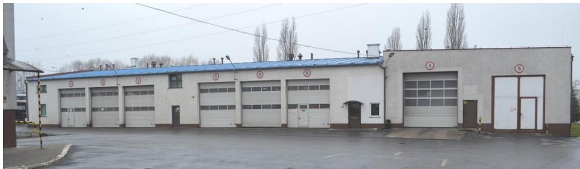
foto 17 – ST 3/103 elewacja wschodnia
