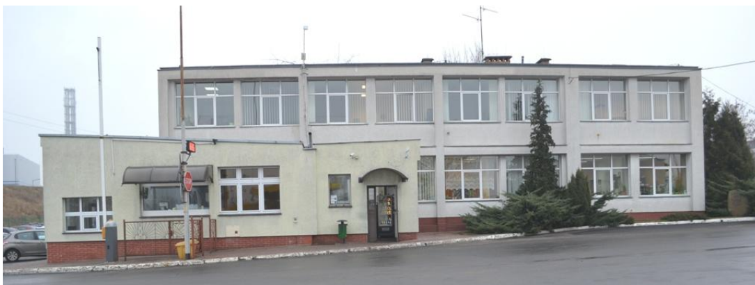
foto 27 – ST 5/105 elewacja zachodnia
