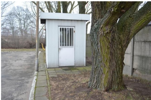
foto 62 – ST 494/109 elewacja północna
