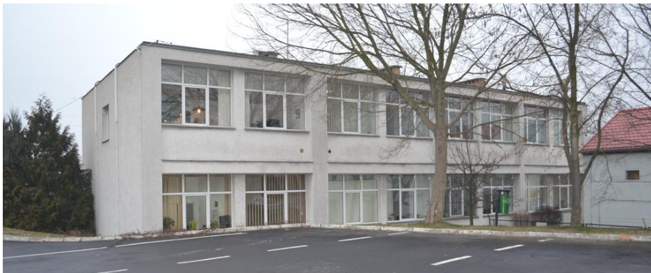
foto 29 – ST 5/105 elewacja wschodnia
