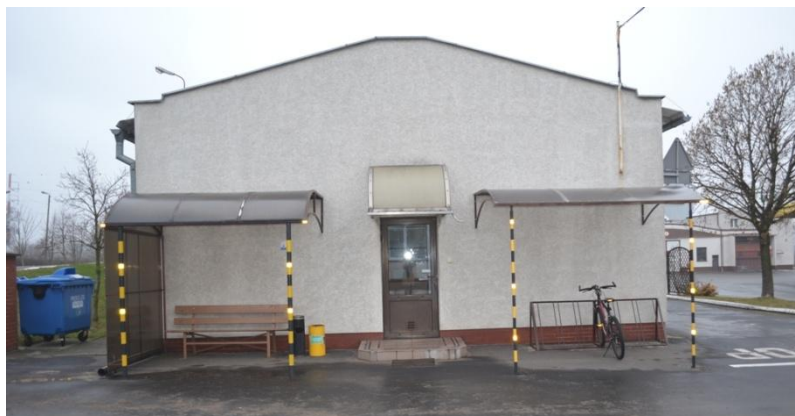
foto 12 – ST 2/109 elewacja wschodnia
