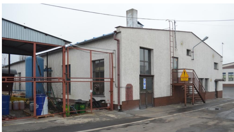
foto 19 – ST 3/103 elewacja południowa
