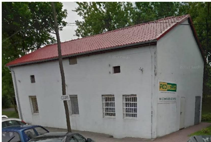
foto 11 – ST 1/105 elewacja północno-zachodnia
