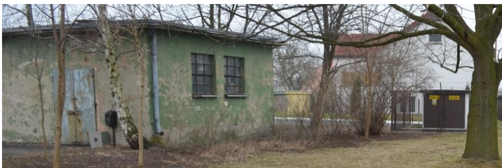
foto 40 – ST 7/109 elewacja północna
