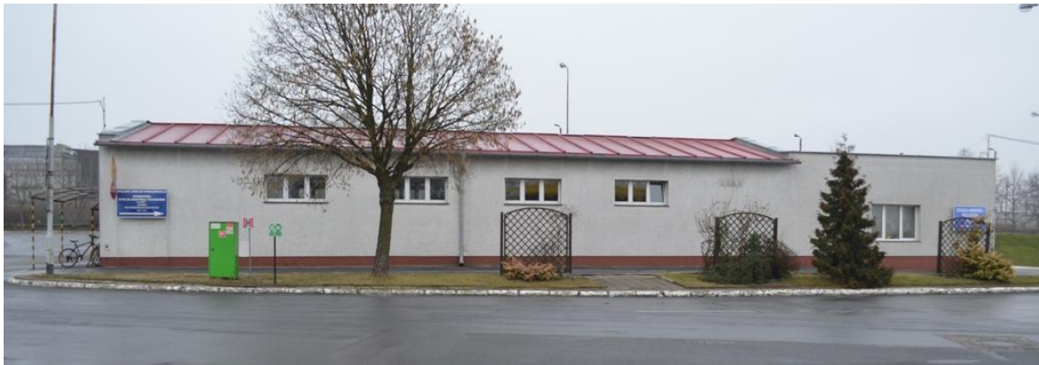
foto 16 – ST 2/109 elewacja północna
