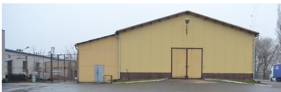
foto 49 – ST 10/104 elewacja północna
