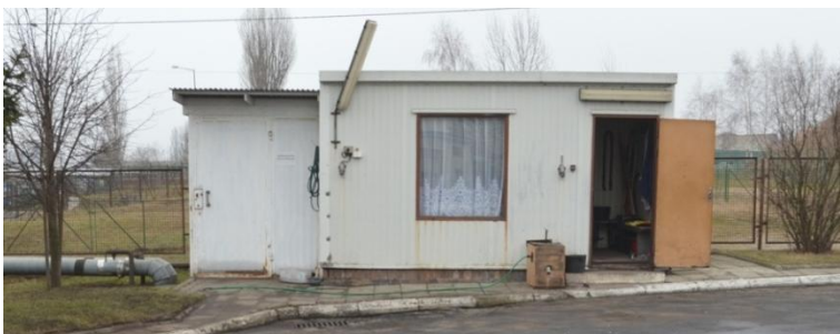
foto 58 – ST 43/109 elewacja południowa
