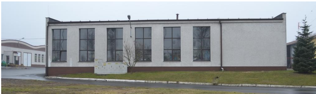
foto 46 – ST 9/103 elewacja północna
