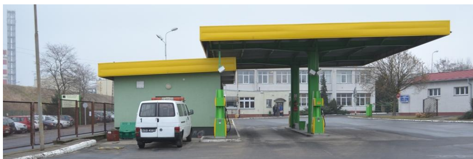
foto 44 – ST 8/103 elewacja zachodnia
