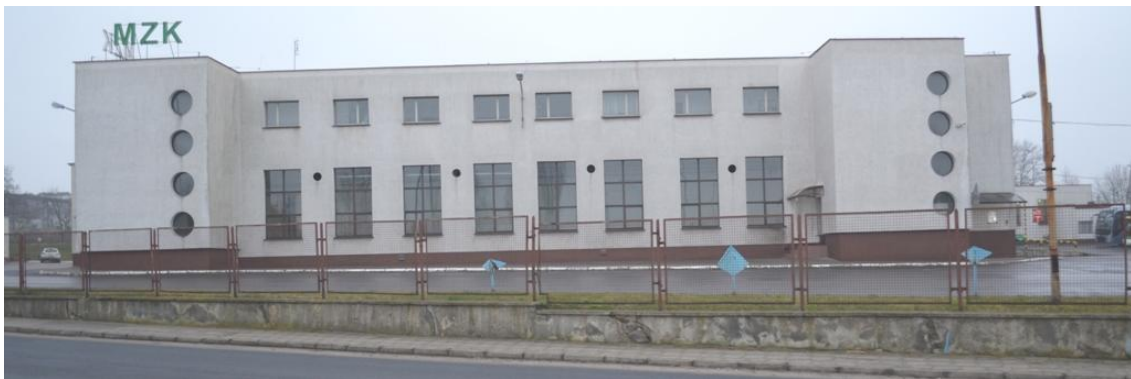
foto 21 – ST 4/103 elewacja północna
