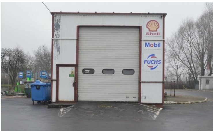
foto 54 – ST 40/103 elewacja północna
