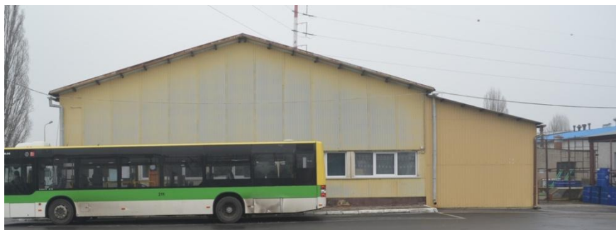
foto 51 – ST 10/104 elewacja południowa
