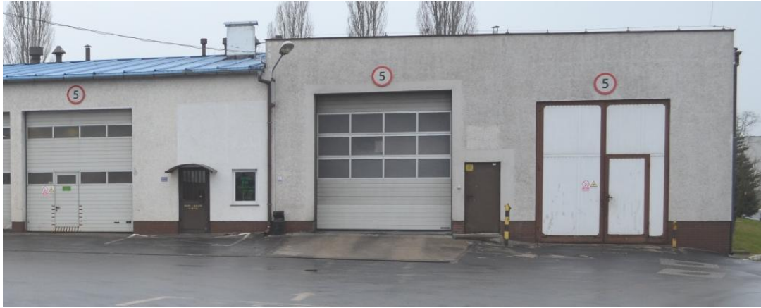
foto 45 – ST 9/103 elewacja wschodnia
