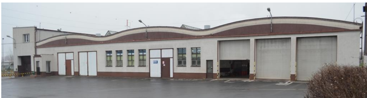
foto 23 – ST 4/103 elewacja zachodnia
