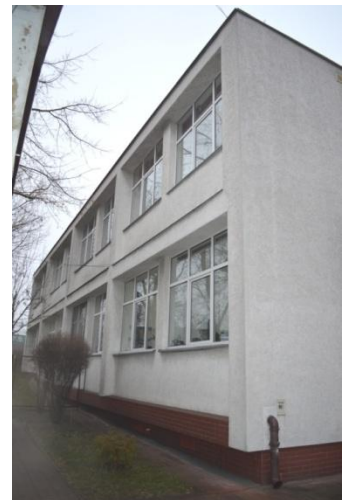
foto 30 – ST 5/105 elewacja wschodnia
