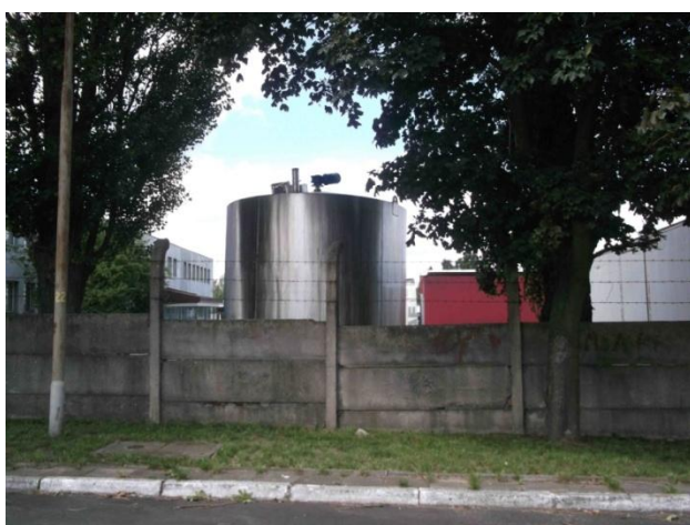
foto 69 - instalacje technologiczne zlokalizowane na terenie działki sąsiedniej (41/6) w bezpośrednim sąsiedztwie działki 44/4
