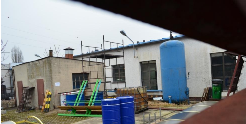
foto 20 – ST 3/103 elewacja zachodnia
