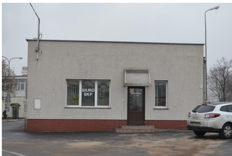
foto 13 – ST 2/109 elewacja zachodnia
