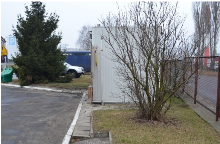
foto 61 – ST 43/109 elewacja wschodnia
