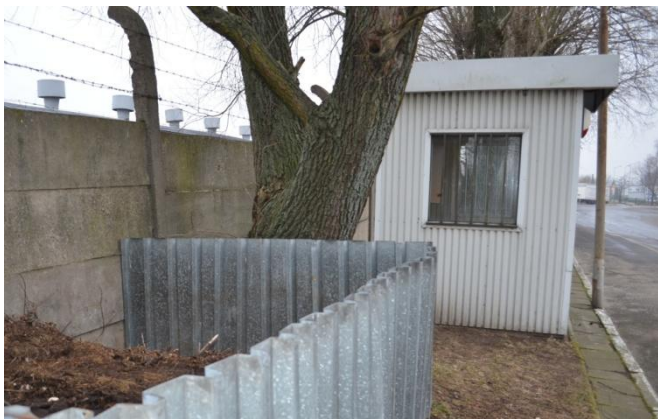
foto 64 – ST 494/109 elewacja południowa
