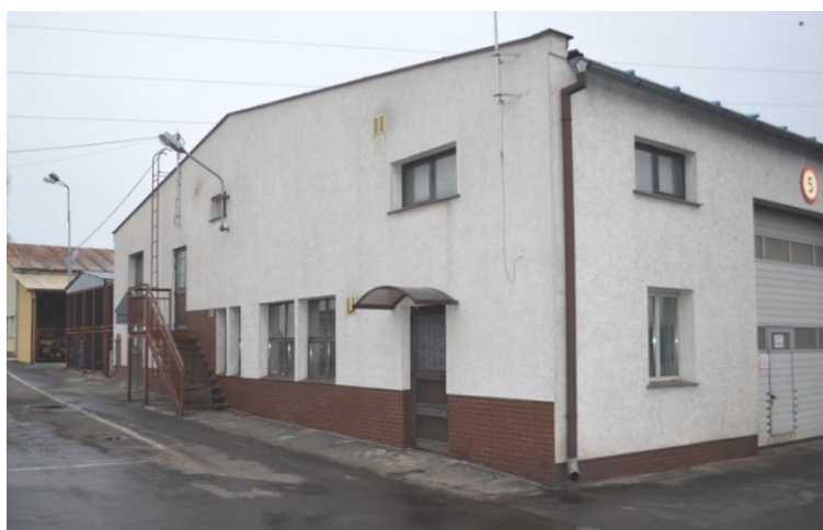
foto 18 – ST 3/103 elewacja południowa
