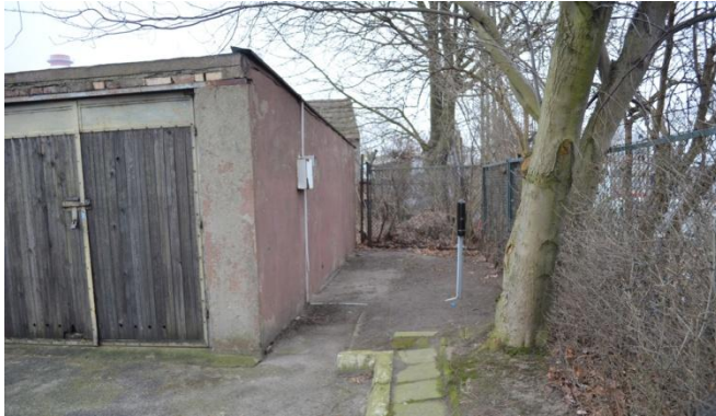
foto 53 – ST 21/102 elewacja południowa
