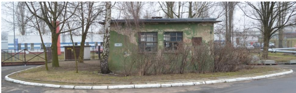
foto 38 – ST 7/109 elewacja południowa
