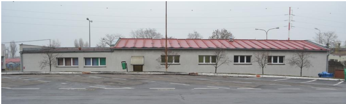
foto 15 – ST 2/109 elewacja południowa
