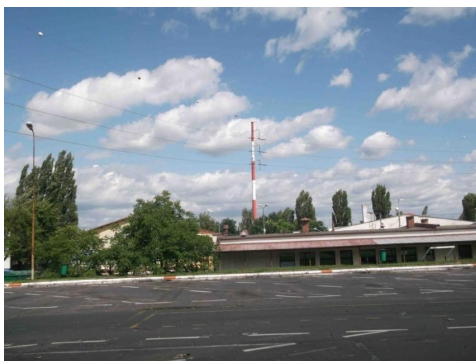
foto 72 - widok na napowietrzną linię wysokiego napięcia EW 220kW (pas techniczny)
