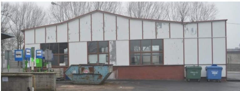
foto 57 – ST 40/103 – elewacja wschodnia
