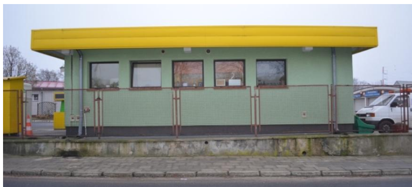
foto 43 – ST 8/103 elewacja północna
