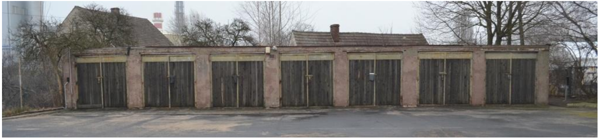
foto 52 – ST 21/102 – elewacja zachodnia
