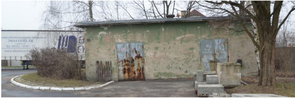
foto 37 – ST 7/109 elewacja wschodnia
