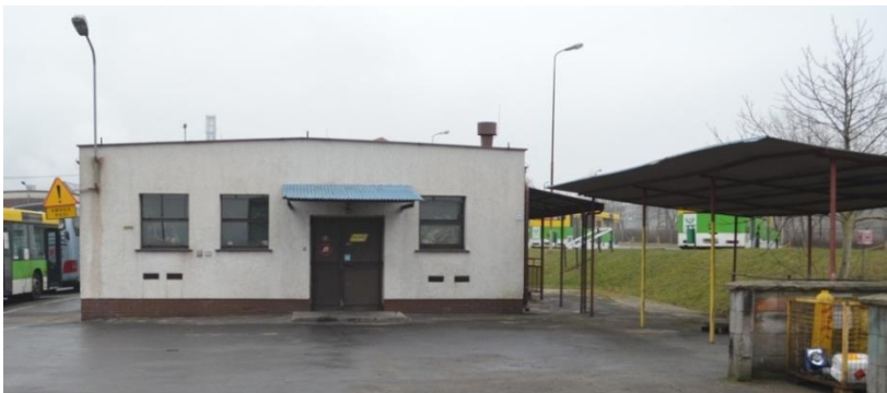
foto 31 – ST 6/109 elewacja zachodnia
