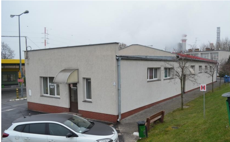
foto 14 – ST 2/109 elewacja południowo-zachodnia
