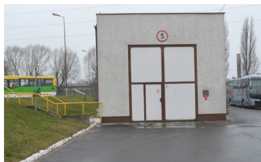
foto 32 – ST 6/109 elewacja wschodnia
