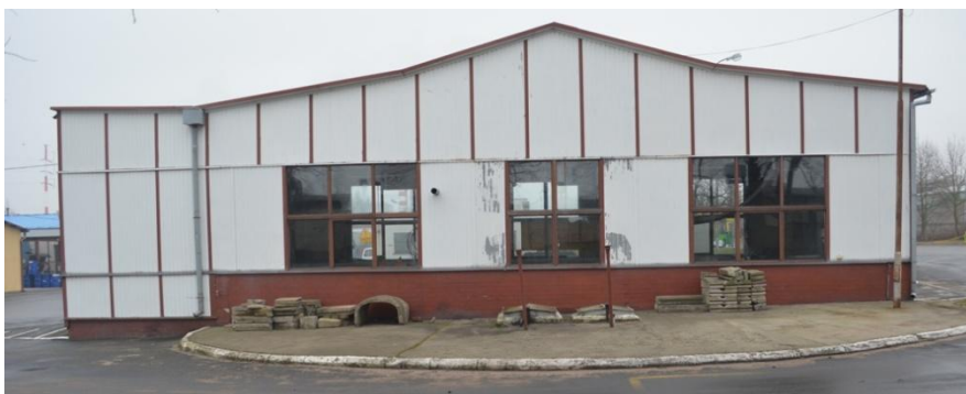
foto 55 – ST 40/103 elewacja zachodnia
