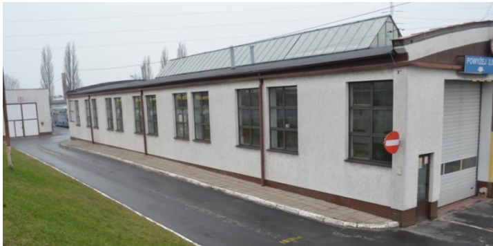
foto 25 – ST 4/103 elewacja południowa
